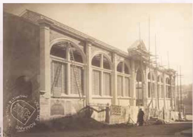
■ Construction des halles.
