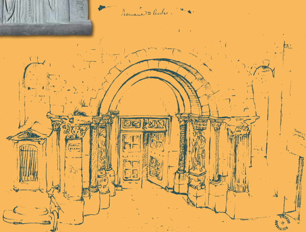
Vue de l'intérieur de l'église de Saint-Barnard
