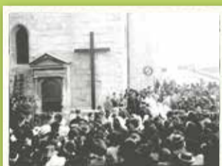
Mise en place de la croix monumentale du « Grand Voyage », 1940.
