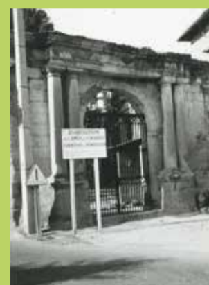
Les premiers travaux de restauration menés au Calvaire dans les années 1970. © M. Taly
