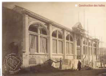
■ Construction des halles
